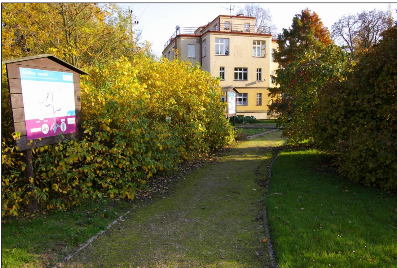
Vila Chigirinski do roku 1996 sloužila jako internát SZeŠ Dalovice. Je to architektonicky kvalitní objekt zralý na památkovou ochranu (architekt Karl Ernstberger). Po rekonstrukci poskytne potřebné zázemí na práci s veřejností.
